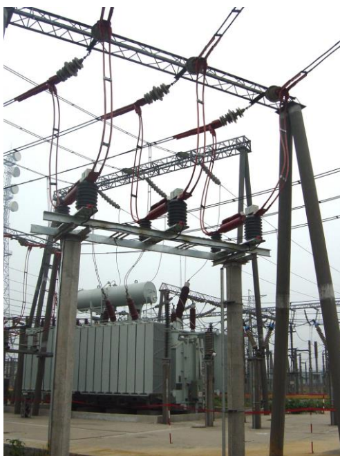
(i) 主变 35kV 侧出口
