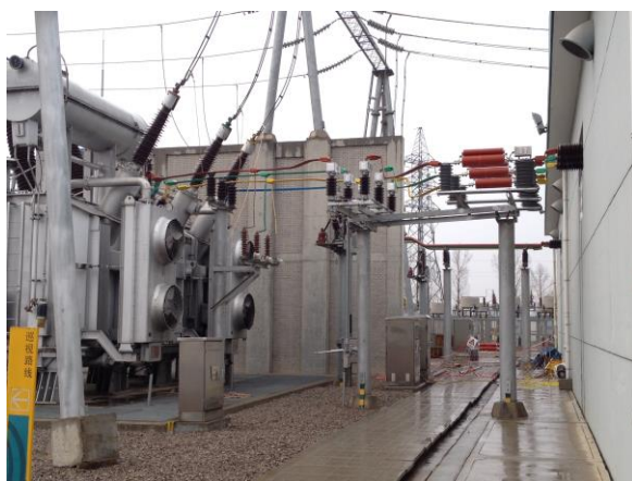
(j) 主变 35kV 侧出口
