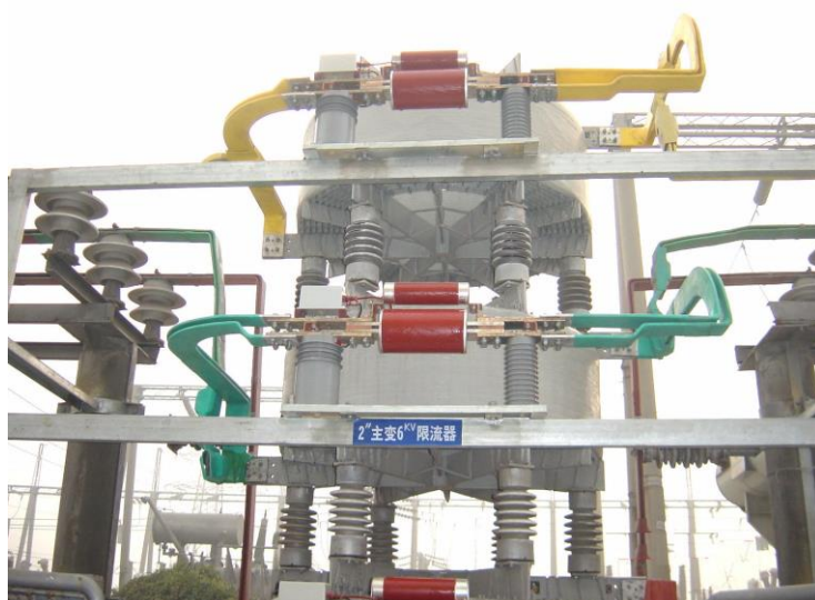
(c) 户外安装旁路限流电抗器
