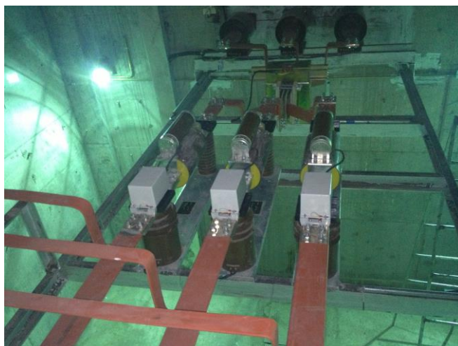
(e) 户内发电机出口安装
