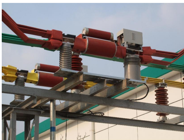
(g) 主变 10kV 侧出口
