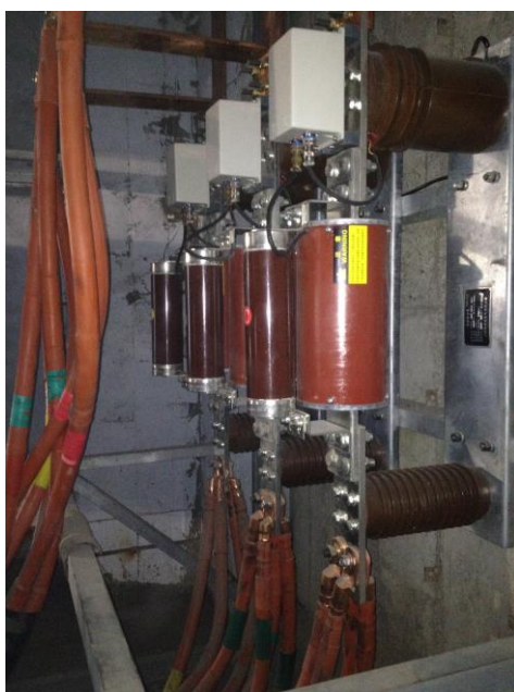
(f) 户内发电机出口墙面安装
