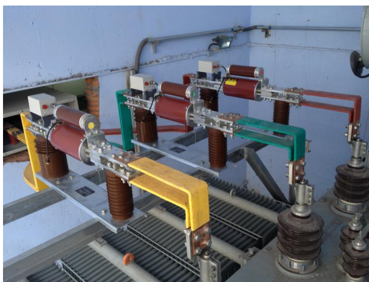
(d) 户内发电机出口安装
