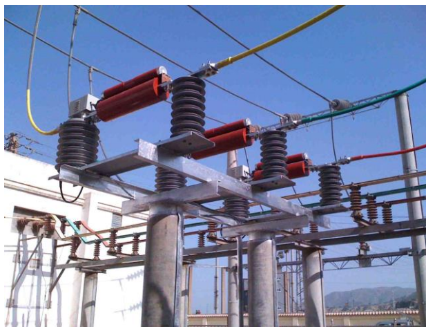
(h) 主变 35kV 侧出口
