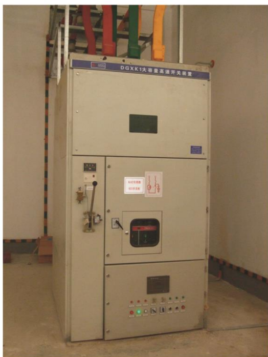
图14 DGXXK1-5 GG1A (隔离开关+DDXK1+真空断路器+隔离开关)
