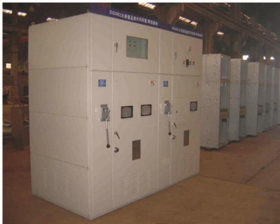
图15 DGXK1-5 KYN28双柜：（隔离开关+DDXK1）柜+（真空断路器+隔离开关）柜
