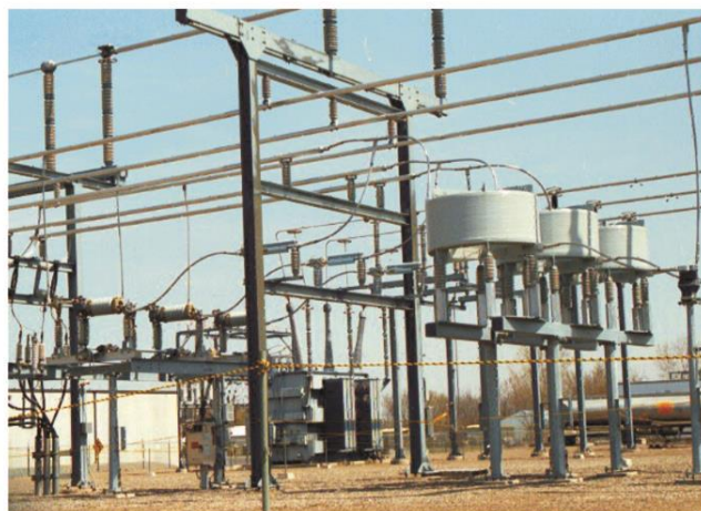
(h)户外-旁路35kV限流电抗器
