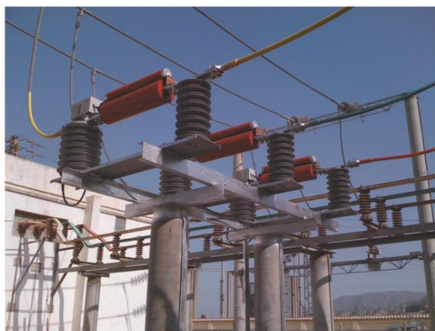
(j)户外-大容量变压器35kV侧快速短路保护 (软母线桥安装)
