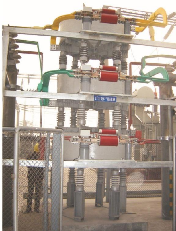
(d) 户外-旁路6kV限流电抗器 (水平分层安装)
