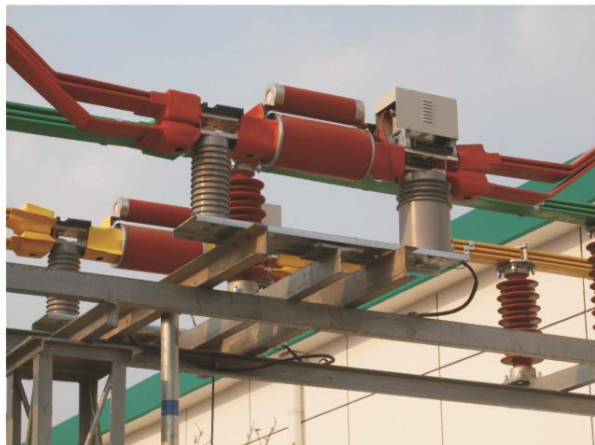
(e)户外-主变压器10kV侧快速短路保护
