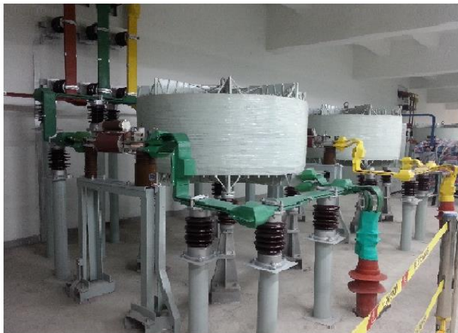
(a) 户内-旁路 10kV 限流电抗器 (水平安装)
