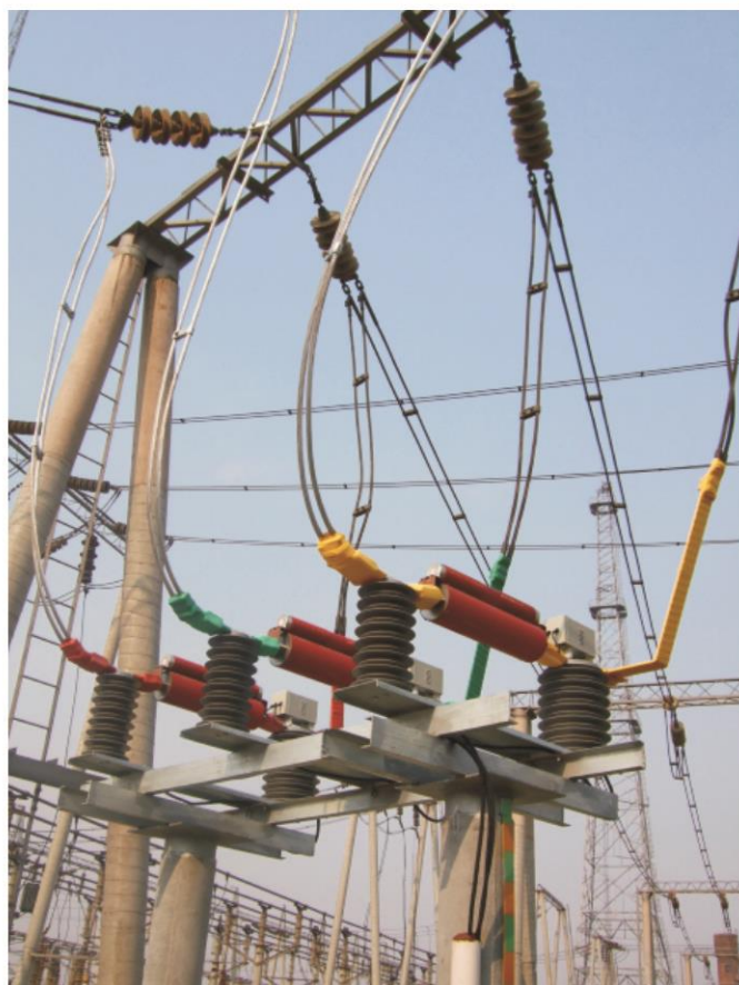
(k) 户外-大容量变压器35kV侧快速短路保护 (由II型杆过桥线接入)
