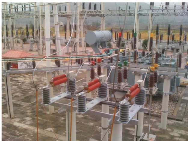
(g)户外-大容量变压器35kV侧快速短路保护
