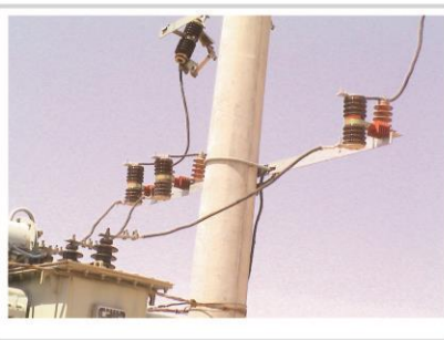
FZQ1-II 配电变压器防雷阻波器
