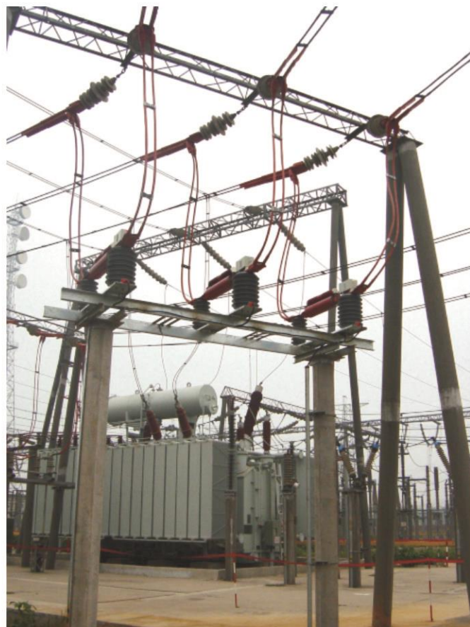
(l) 户外-大容量变压器35kV侧快速短路保护 (由II型杆过桥线接入)
