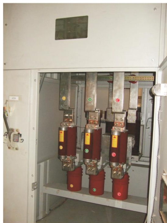
图14 DGXXK1-5 GG1A (隔离开关+DDXK1+真空断路器+隔离开关)
