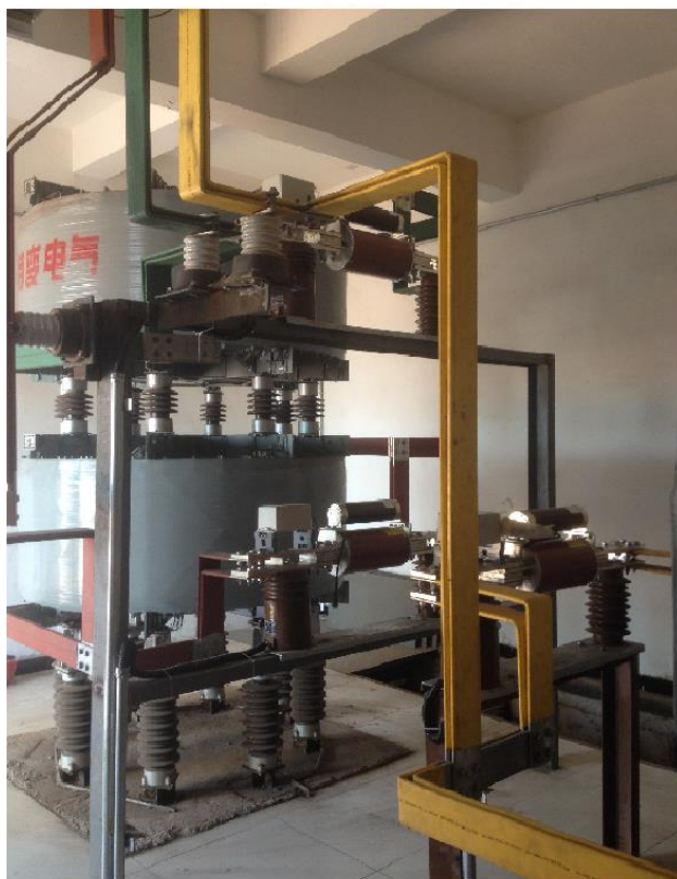
(c) 户内-旁路10kV限流电抗器 (竖直安装)
