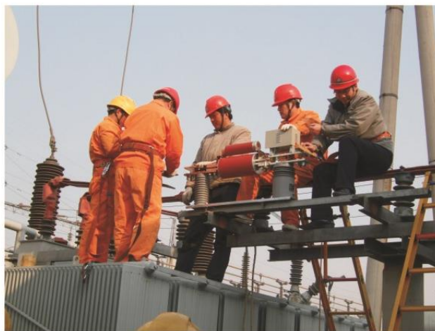
(b) 户外-发电机出口快速短路保护
